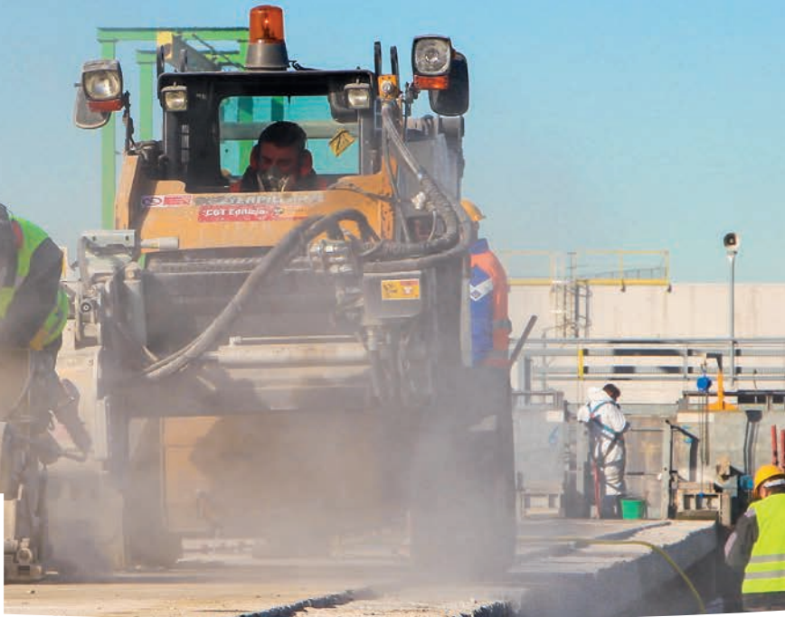
Beton verwijderen met speciale frezen
