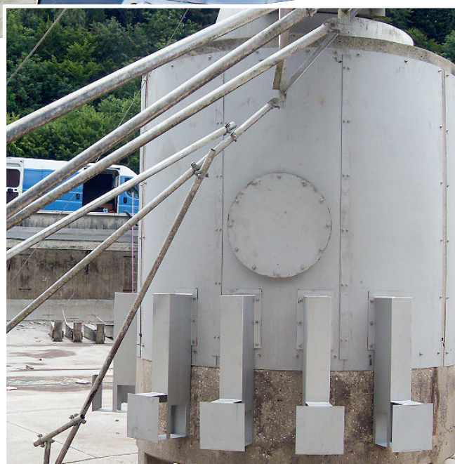
Bekleding van de ruimerbrug van roestvast staal
