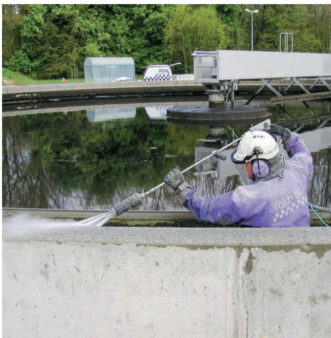
... hogedrukreiniger met 2500 bar aan het werk
