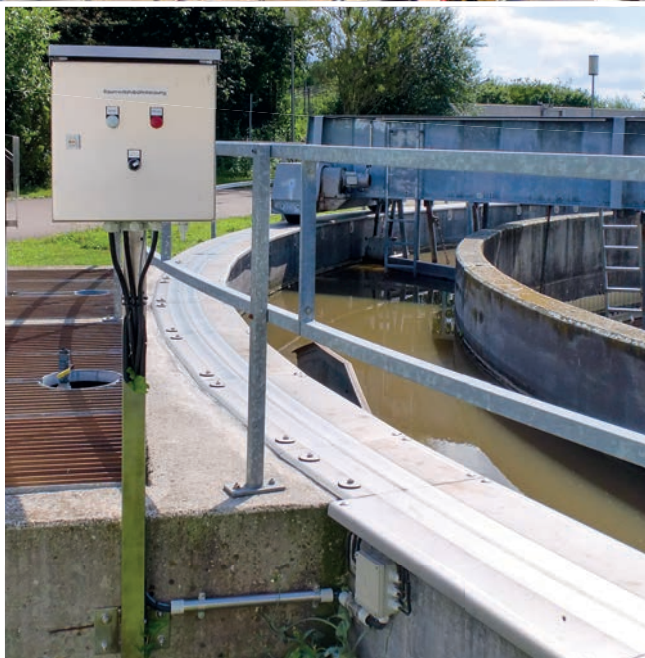
Ronde tank na sanering met verwarmde omlooprand
