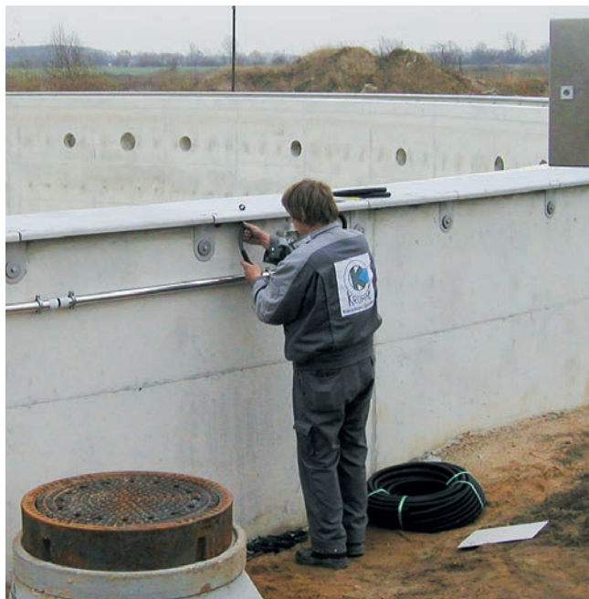
Elektroinstallatie aan nieuwbouw
